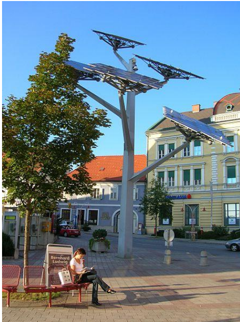
FIGURA 4 - Árvore fotovoltaica na Áustria.
